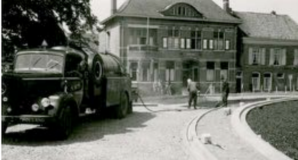
▲ Verbetering van het wegdek bij de afslag Bovenhavenstraat / Graafschap. Het precieze jaar is onbekend maar moet halverwege de jaren vijftig van de twintigste eeuw zijn geweest.
